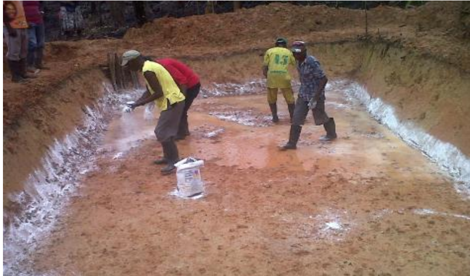
Figura 91. Encalado de estanque
