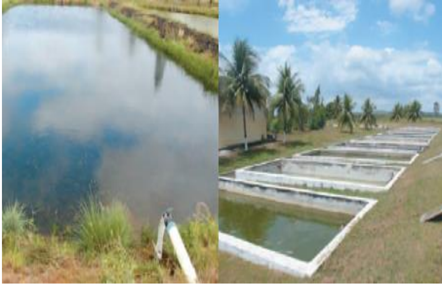
Figura 86. Estanques y tanques.
