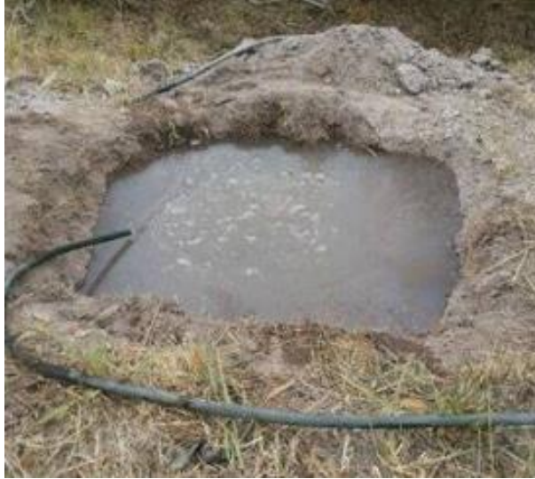
Figura 85. Calicata con agua
