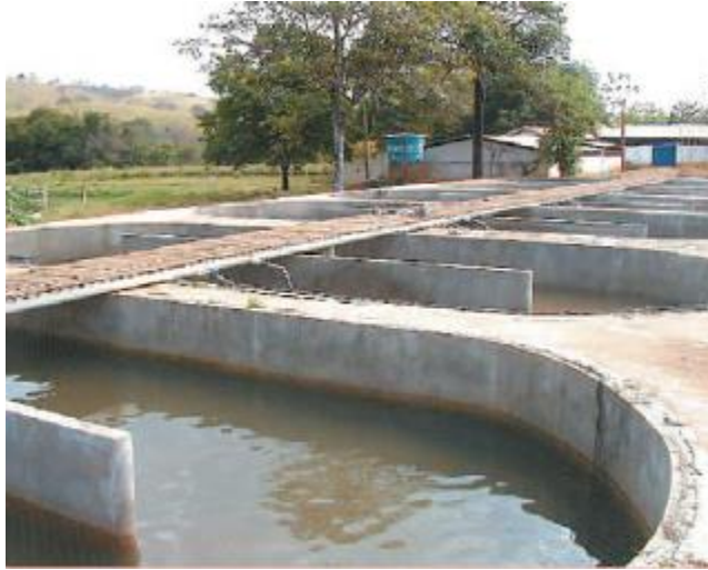
Figura 81. Sistema de raceways.
